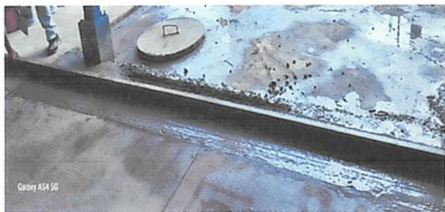
Foto 3: Finalización reparación tubería de drenaje.
