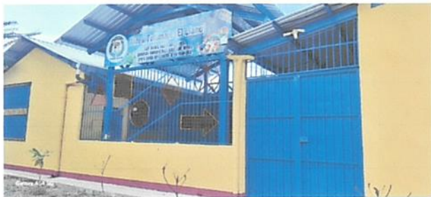
Foto 1: Finalización de paredes y pintura.
