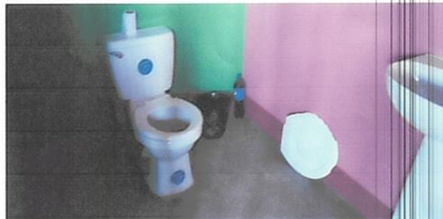
Foto 2: Finalización instalación y reparación de baño.
