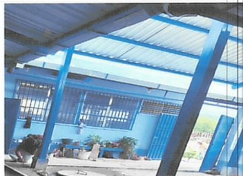
Foto 4: Finalización construcción de galera.
